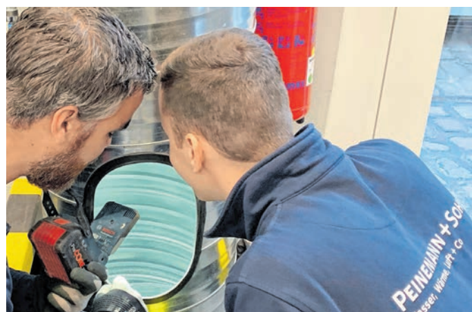
Zum Aufgabenbereich der SHK-Ausbildung zählen auch Wartungsarbeiten wie die Kontrolle eines Lüftungsrohrs auf Fremdkörper.
